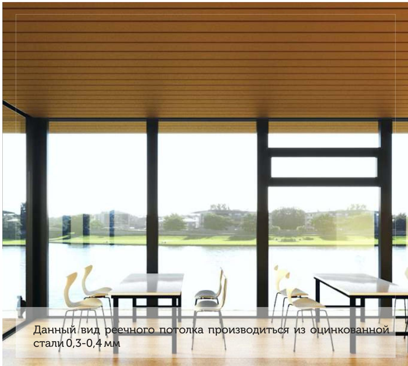
Данный вид реечного потолка производиться из оцинкованной стали 0,3-0,4 мм
